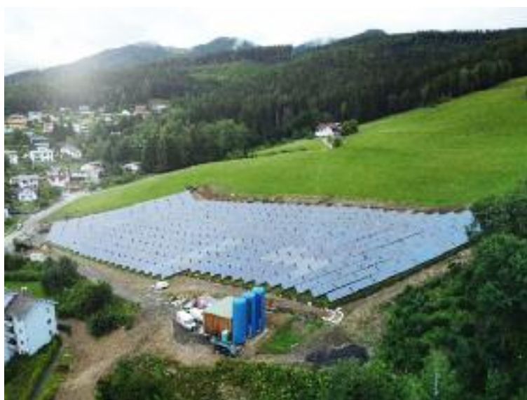
Die Großsolaranlage in Mürzzuschlag versorgt 300 Wohnungen mit Wärme aus der Sonne.
