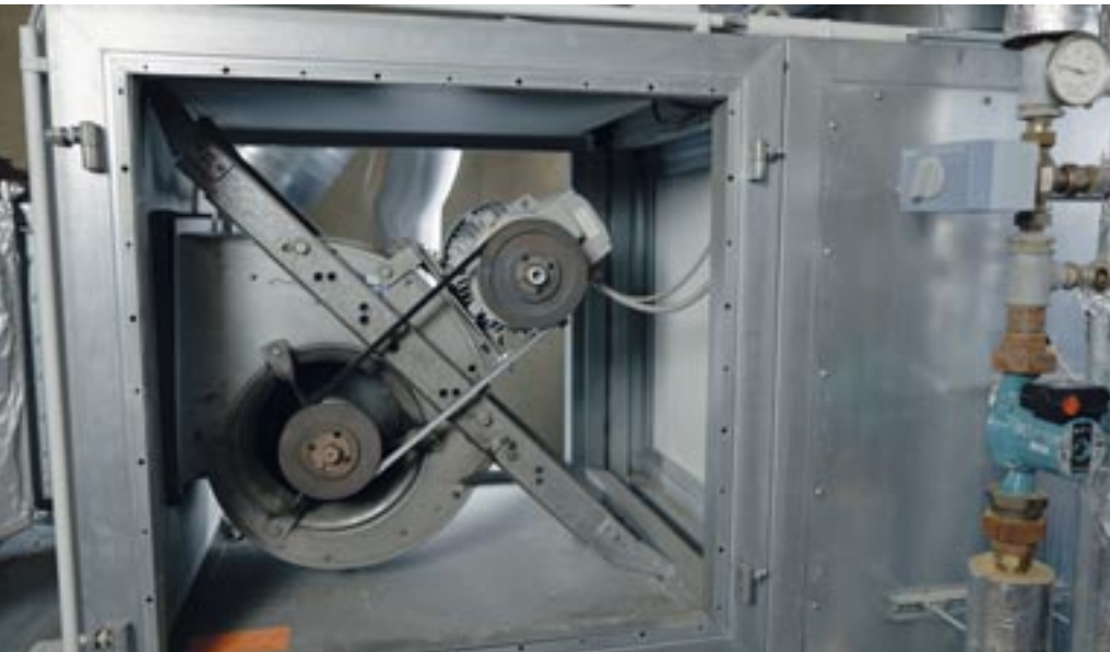
Eine neue Anlage ist deutlich teurer als der reine Austausch von Ventilatoren.
