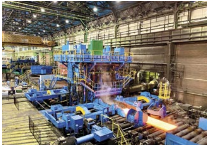
Das neue Grobblechgerüst bei Erdemir in der Türkei ermöglicht größere Walzkräfte.
